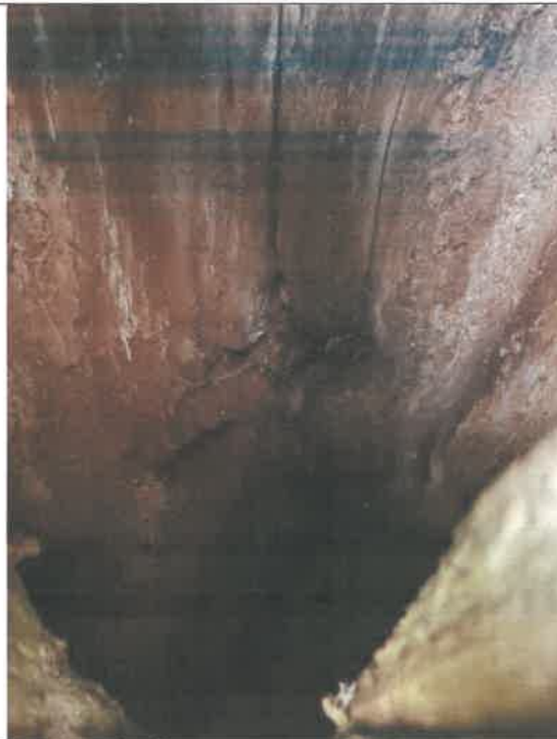
Fot. 6. Ubytek kominowy w pniu
