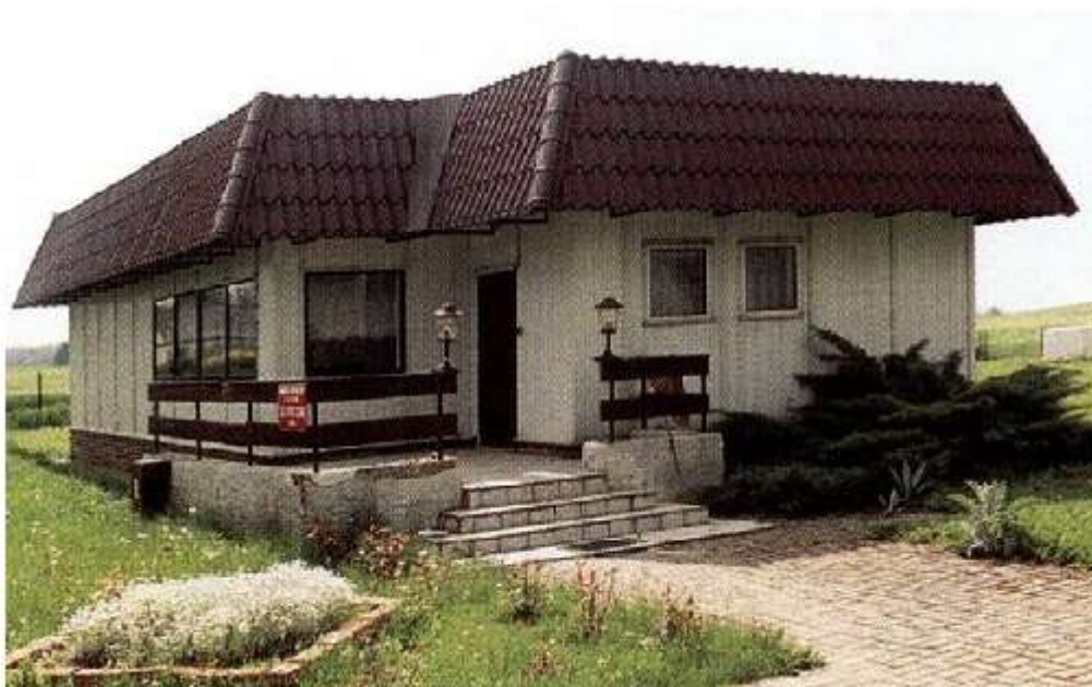
Stacja uzdatniania wody w Kunowice
